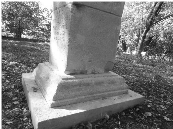
Skala ubytków w dolnej części obiektu, są także wyżej
