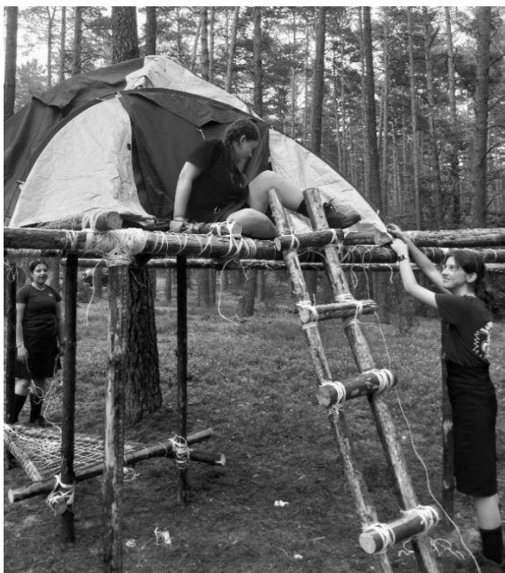
Budowa platformy na obozie, fot. ks. P. Stasieczek
