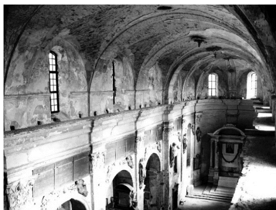
Kolegiata w Ołyce, sklepienie, stan obecny
