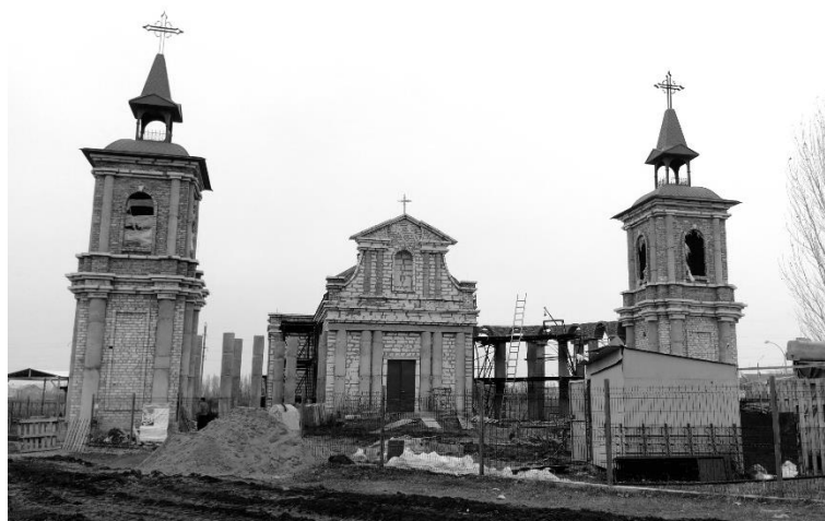
Kościół w budowie w Jużnoukraińsku
