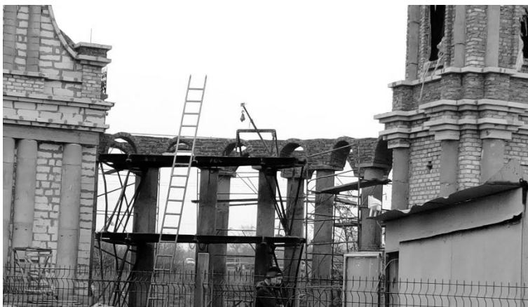
Kościół w budowie w Jużnoukraińsku
